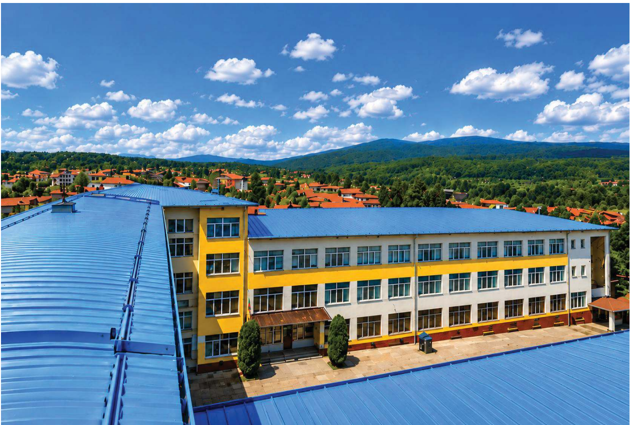
Ремонт на покрив на СУ „Св.св.Кирил и Методий“, гр. Велинград
